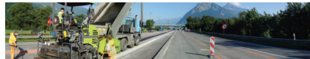
Belagseinbau mit Kleinfertiger neben Rinne
