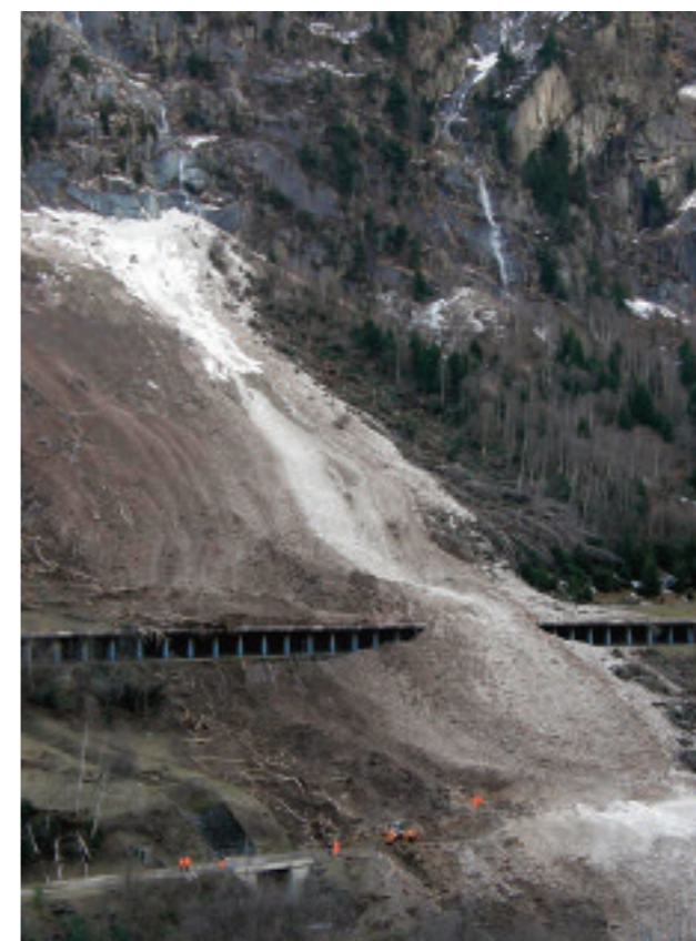
Lawinengalerie Wilerplanggen nach Lawinenniedergang
