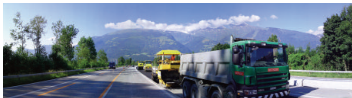
Einbau ACF 22 ganze Mittelstreifenbreite 3,5 m
