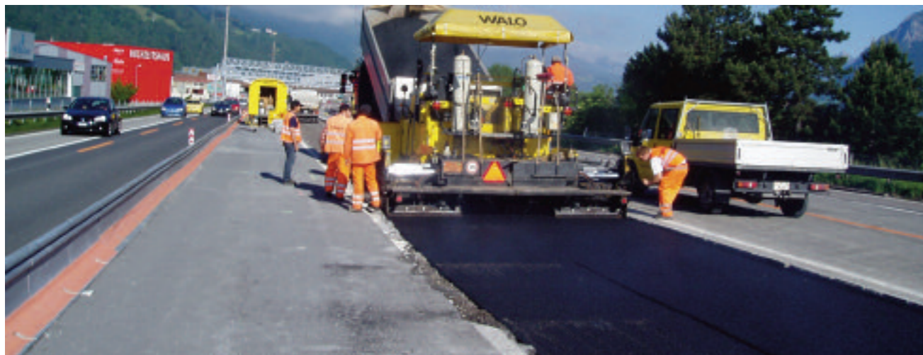
Belagseinbau auf der ganzen Mittelstreifenbreite (4 Meter)
